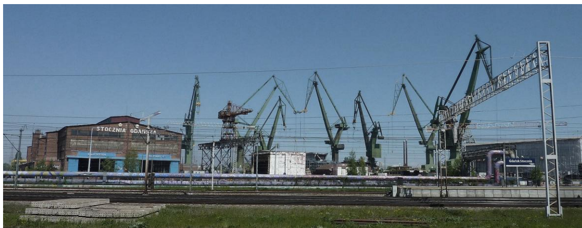
Ryc. 7. Hala kadłubowni i traserni [3B] z ikonycznym sztydem „Stocznia Gdańska”, obok – z prawej strony żuraw estakadowy, w tle żurawie stoczniowe produkcji firmy Kone (fot. E. Nakonieczna, 2026)
